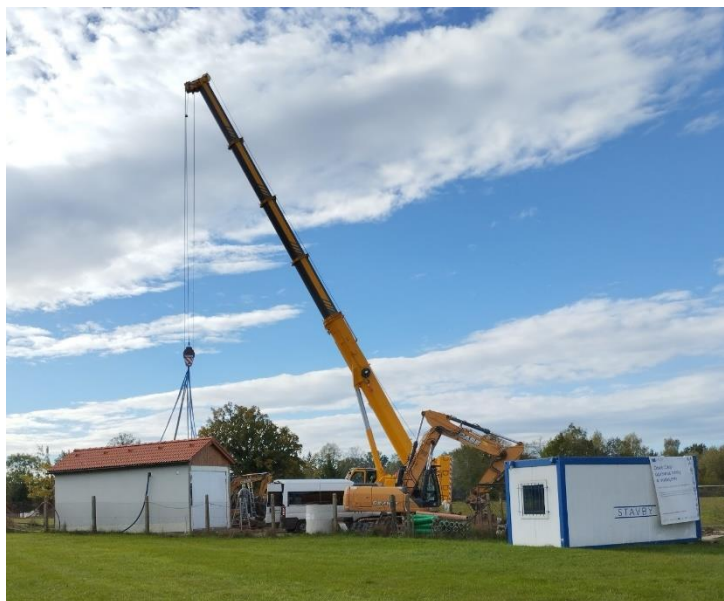
fotografie ze započatých prací
