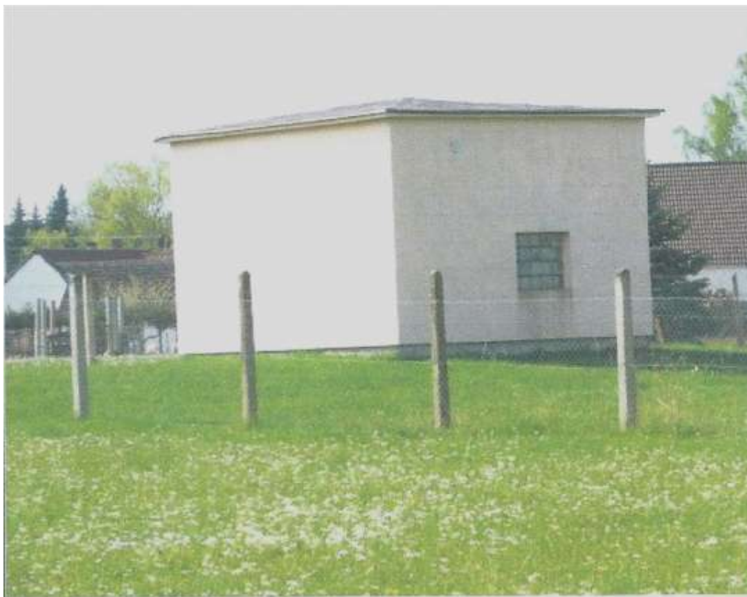
Vodárna je již v majetku obce
