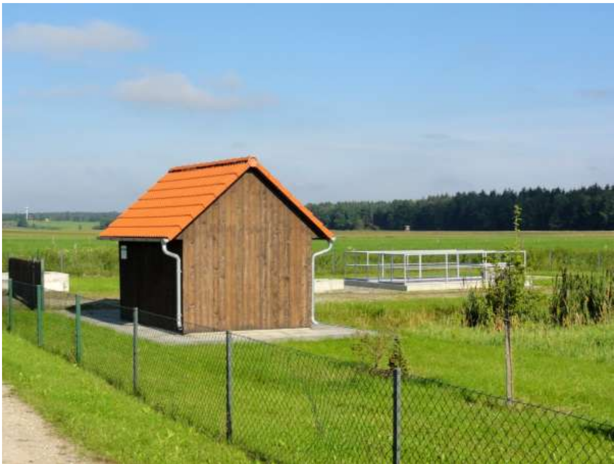
Objekt čistírny odpadních vod
