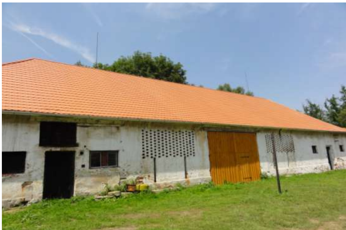
Nová střecha a vrata hospodářské budovy
