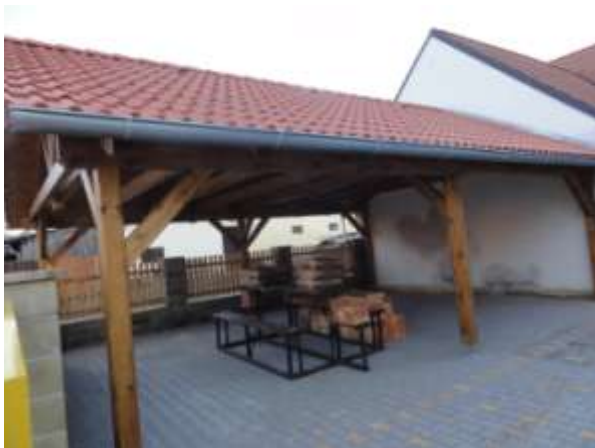
Pergola před dokončením
